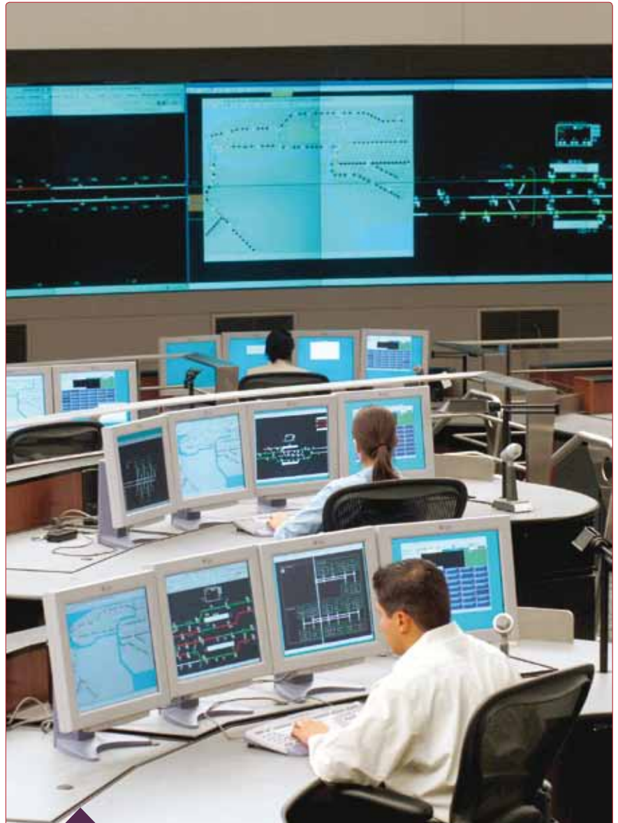
Dans l'usine digitale, la place de la supervision sera prépondérante, ici la salle de gestion du métro de New-York.
